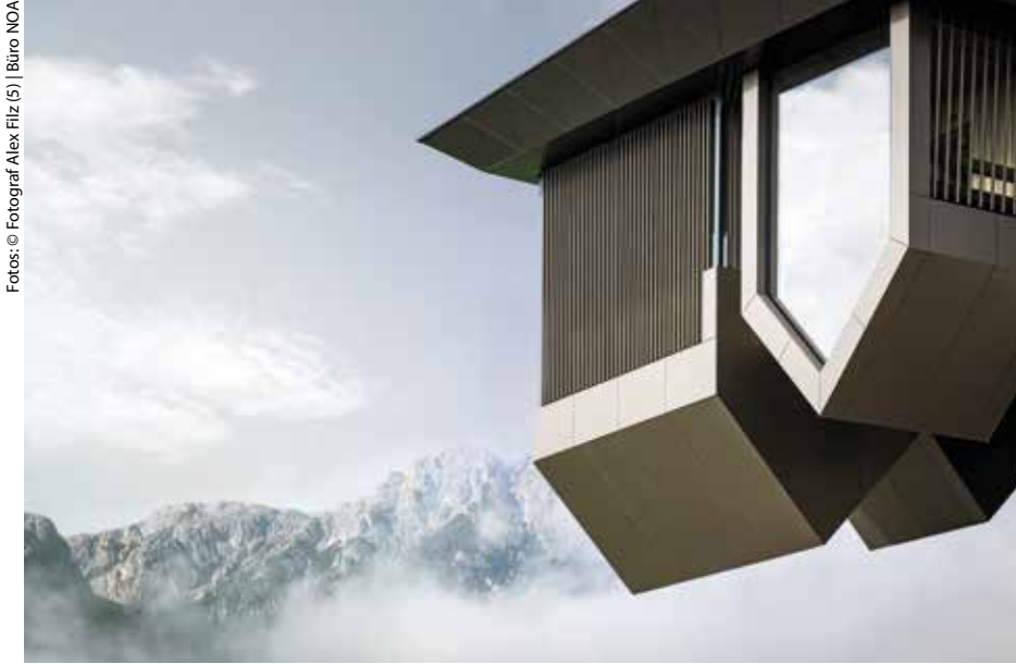
Die Farb- und Materialwahl steht im Einklang mit der Landschaft: Aluminiumpaneele in natürlichen Brauntönen verkleiden die Kabinen.
