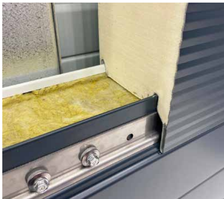
Das neue Pflaum F2 Mineralwoll-Paneel verfügt über zahlreiche Vorteile. Es sind keine zusätzlichen Arbeiten bei der Montage zwischen den beiden Paneelen notwendig.
